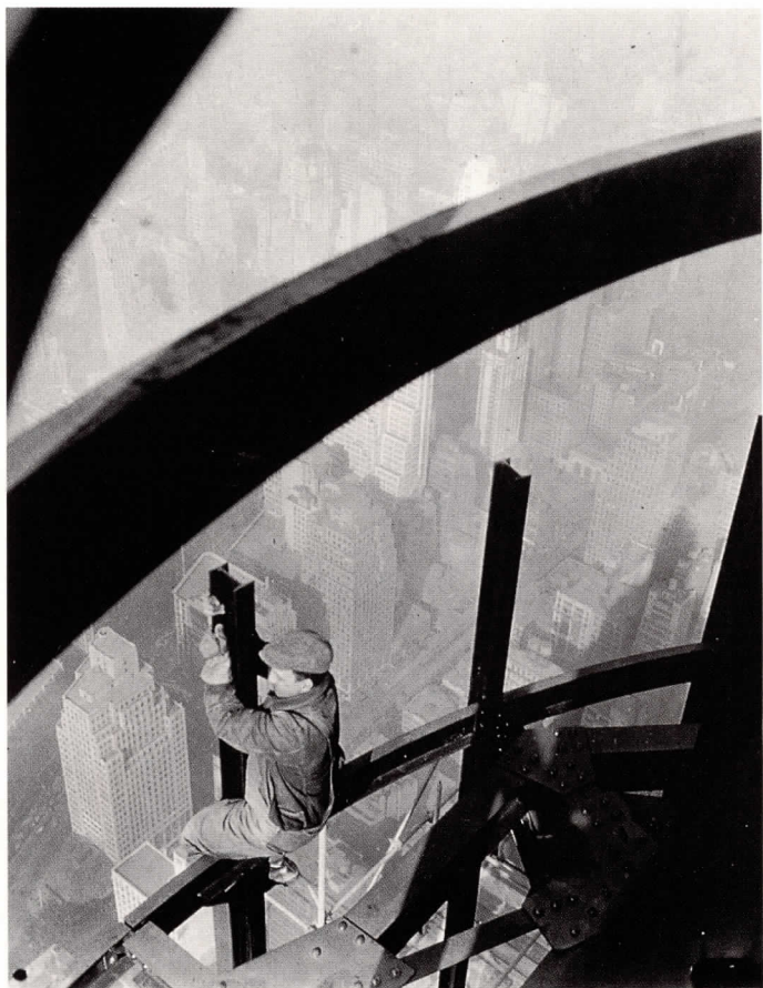
Obrero sobre las vigas de la cúspide del Empire State Building, 1931
