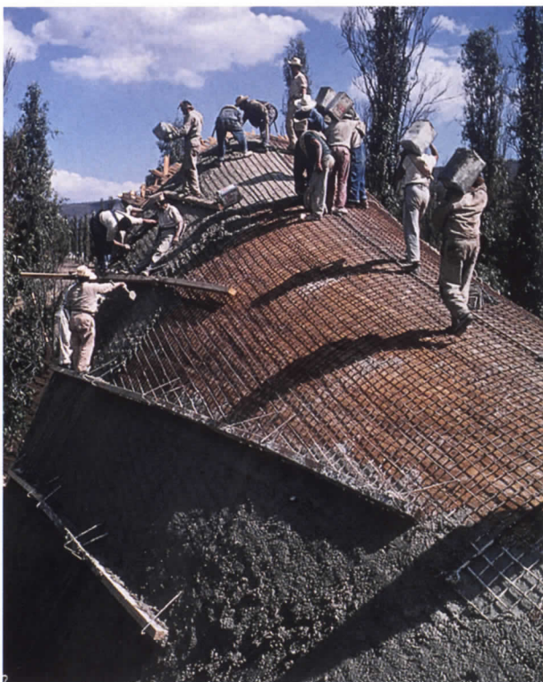
Construcción de Los Manantiales
