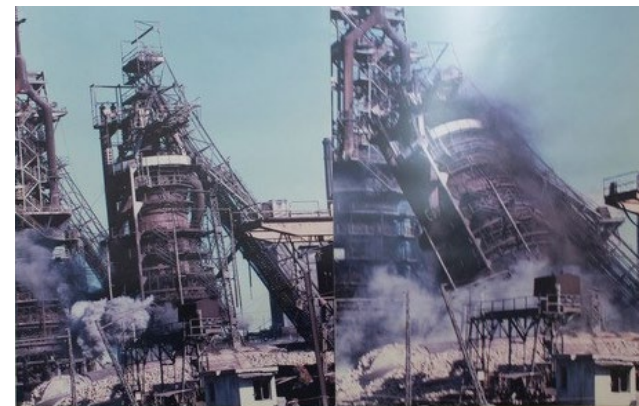
Blast furnaces of Sagunto. "Gerència Pública ya!" campaign, Puerto de Sagunto. CC.OO, Camp de Morvedre
